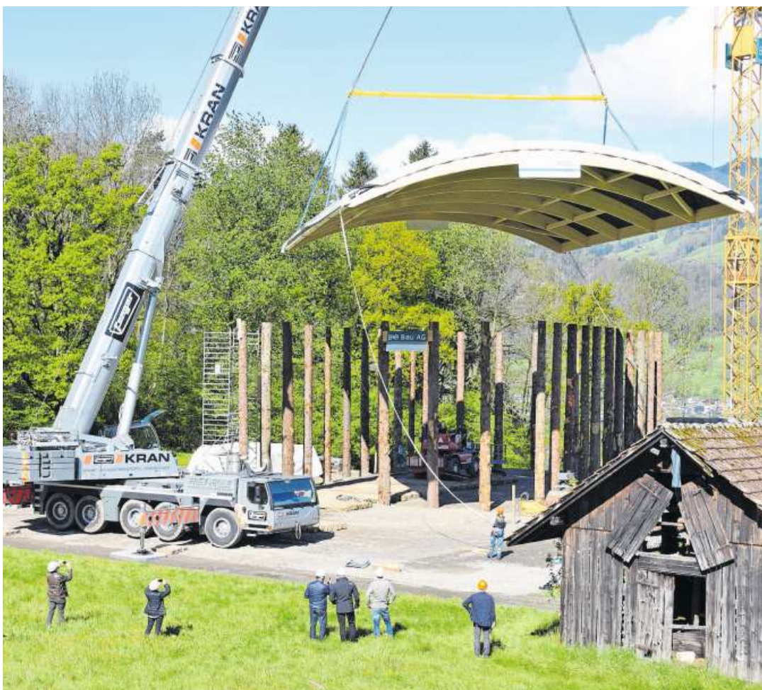
Ein Fanger-Spezialkran bringt das Holzdach an die richtige Position. Für die Feinjustierung der Ecken sorgen Mitarbeiter am Boden. Bild: Adrian Venetz (Sachseln, 5. Mai 2017)
